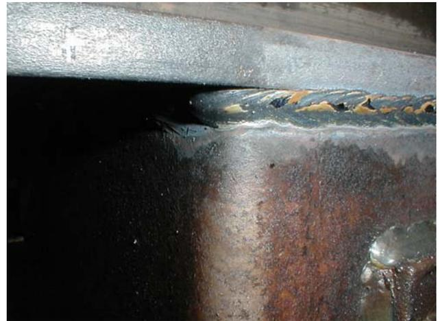
3.4- Soldar los espaciadores de fuelles en la posición según se indica en la siguiente figura. Los discos deben estar apoyados en un 60% de su superficie.
